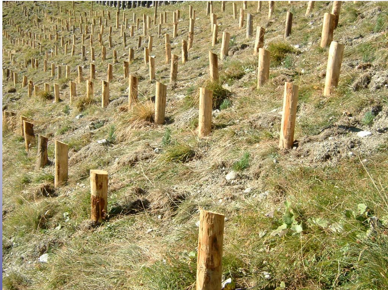
Imboschimenti con pali fermane in località "Bosc di Mur" in Comune di Livigno
